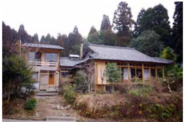
再生工事を経て生まれ変わった「山のツバル」
