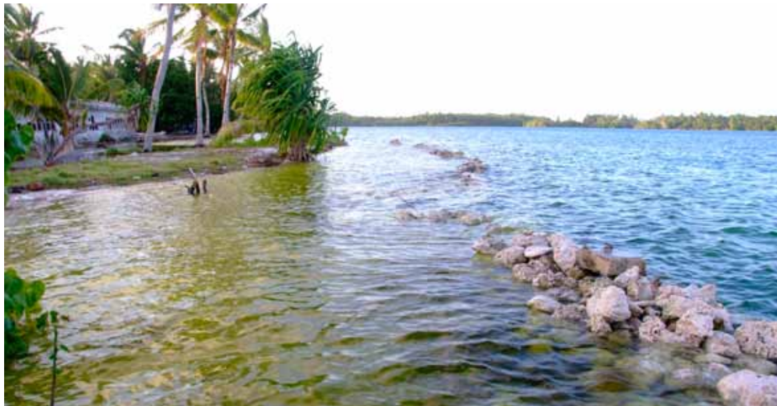
2012年3月8日の浸水被害の様子。昔島民が作った土手を越えて水が入ってきている
